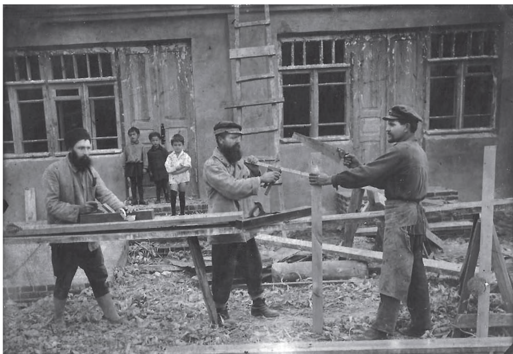
Плотники за работой в Грозном
